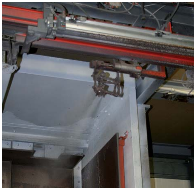
8 – Un dettaglio degli ugelli che umidificano la parete in base all'umidità necessaria per ottenere la giusta viscosità.
