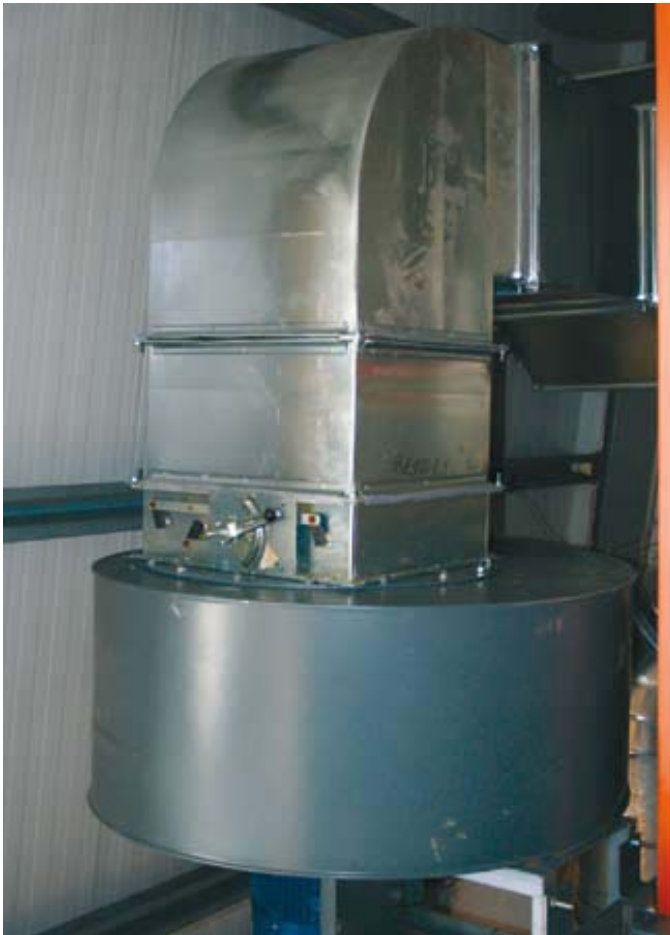
7 - La parte finale del sistema d'aspirazione. Qui l'aria arriva perfettamente filtrata e con un carico di particolato molto inferiore ai limiti di legge. 7 - The final part of the suction plant. Here, the air arrives as perfectly filtered and with a load of particulate that is much lower than the limits established by law.
