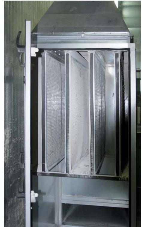
13 e 14 - L'impianto di aspirazione e un suo dettaglio: l'unità filtrante posta ad altezza uomo consente un accesso rapido per gli interventi di manutenzione e pulizia. Detail of the "turn around" plant, which was conceived to rotate the item-holder bar and take it back to the booth in a short time to finish the other side of the fixture.
